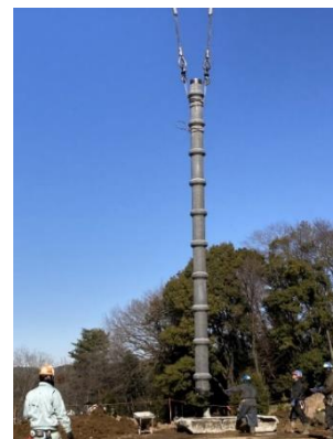
ストックヤード建築工事状況（杭打ち）
